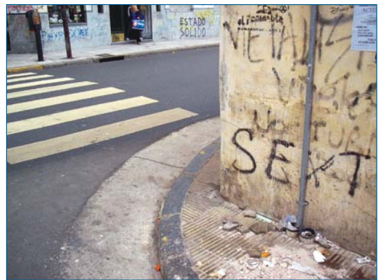
Esquina porteña visualmente polutiva y funcionalmente nula debido a la poca distancia que existe entre el cordón de la calle y la pared
