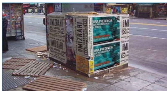
Sistema de ventilación de estación de trenes subterráneos
