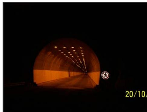
mismo tiene una longitud de 730 m, 8,40 m de ancho y una altura máxima de 6,60 m, con un sistema de iluminación de última generación, proyectada para una velocidad vehicular de 60 km / h, que minimiza el efecto de boca oscura al ingresar en horas diurnas.
