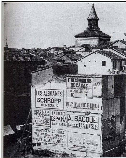
Medianera de la Puerta del Sol (Madrid), 1859
