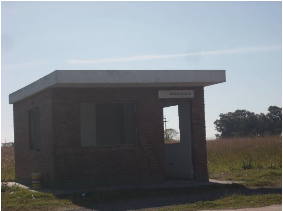
Puesto de vigilancia Zona Franca Aduanera de Santa Fe
