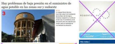
Hay problemas de baja presión en el suministro de agua potable en las zonas sur y sudoeste
