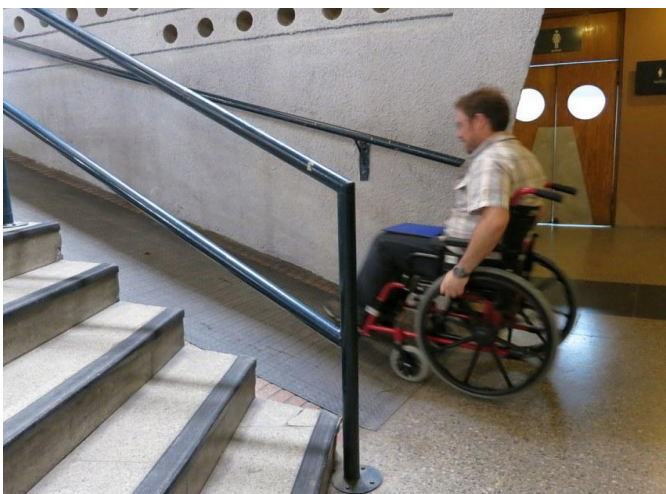
· Rampas de acceso.
