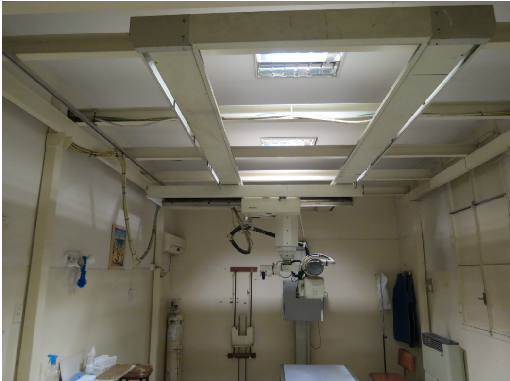
Estructura de sostén y deslizamiento del tubo de Rx
