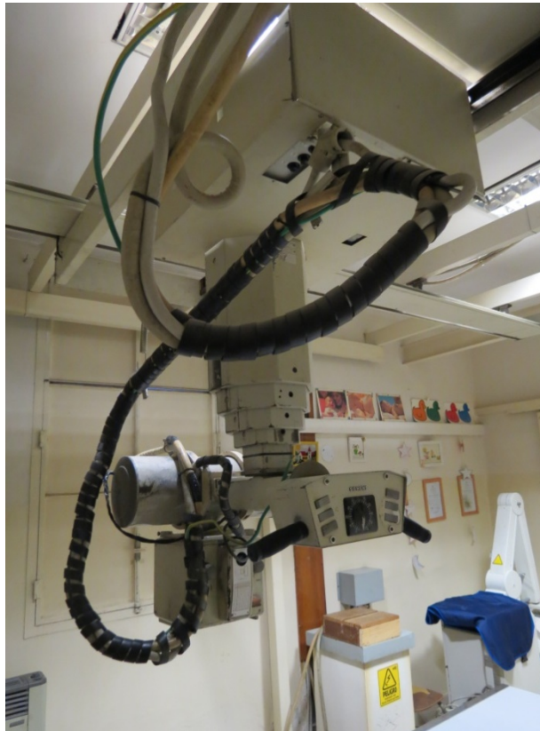
Tubo de Rx (vista superior del brazo mecánico del tubo)
