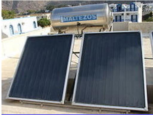
Captador solar plano, también llamado colector solar plano o panel solar térmico, consiste en una caja plana metálica por la que circula un fluido, que se calienta a su paso por el panel.
