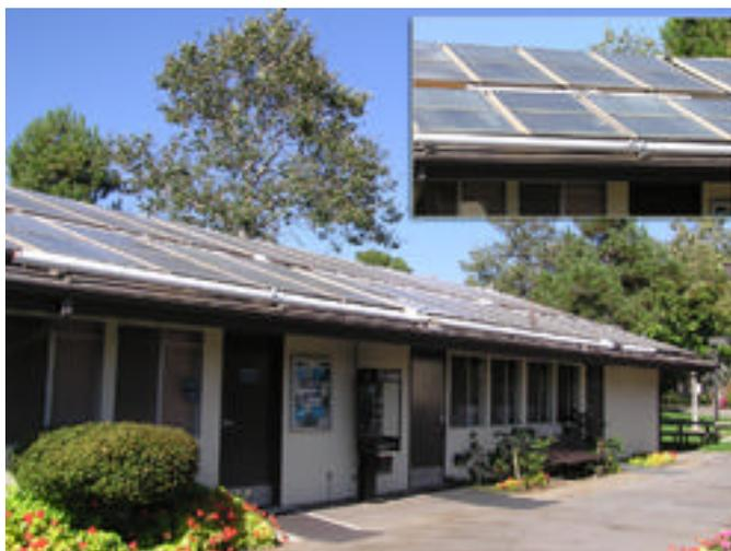
Una lavandería en California, EE. UU., con paneles solares de agua caliente en techo.
