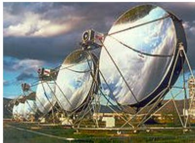
Concentradores parabólicos que recogen la energía solar en Almería, España.
