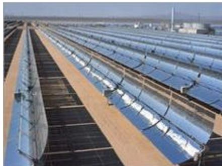
Espejos parabólicos en concentrador solar.
