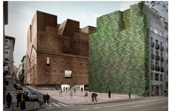
El proyecto parte de una compleja intervención arquitectónica destinada a preservar la envolvente de ladrillo adicionándole una nueva estructura y dejando la planta baja libre manteniendo la plaza.
