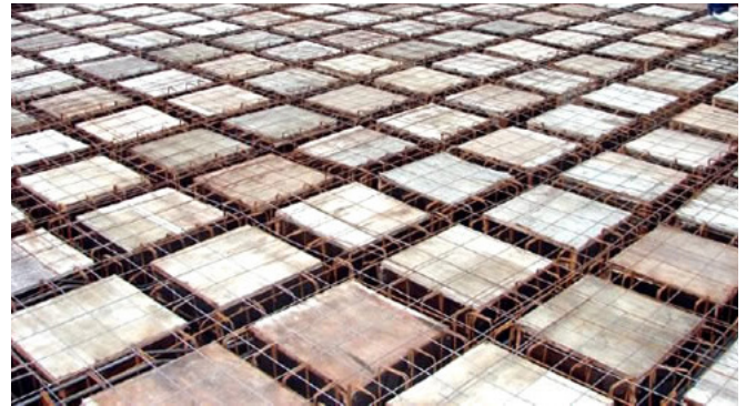
Imagen de armadura de losa casetonada
