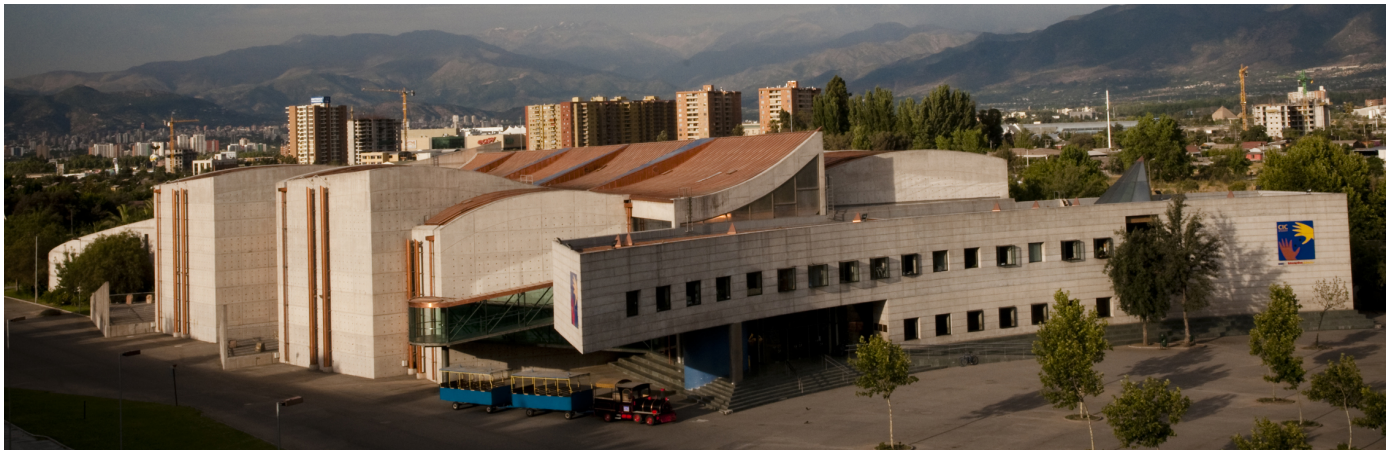
El edificio de siete mil metros cuadrados combina en su estructura acero, hormigón, madera de mañío, vidrio y cobre.
