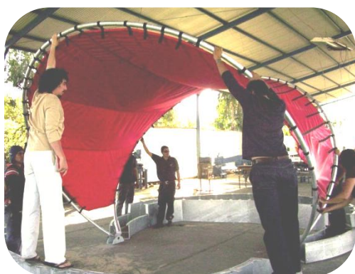
Se componen de una estructura semicircular con una capota que sirve como techo orientable según su uso.
