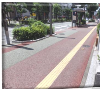
Correcta ejecución en solados de la delimitación de espacios por colores, y franja de mosaico guía para invidentes sobre veredas. Calle céntrica de Fukuoka, Japón.
