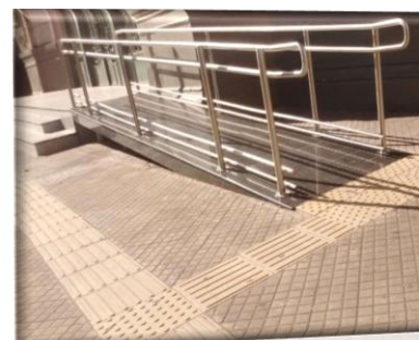
Correcta ejecución de solado de prevención en acera y rampa de acceso, para salvar desnivel. Ciudad de Bs. As.
