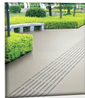
Correcta ejecución del mosaico guía para invidentes. Guangdong, China.
