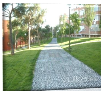
Utilización de texturas en solados (percepción táctil y auditiva).
