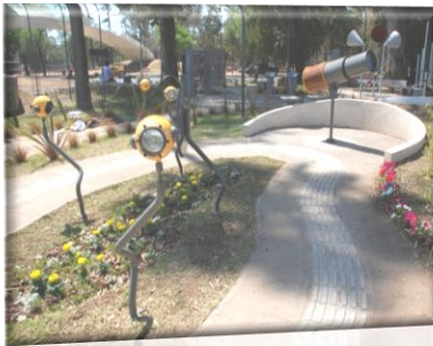
Correcta ejecución del mosaico guía y solado de prevención para invidentes. Jardín de los Sentidos en Nueva Córdoba, Argentina.
