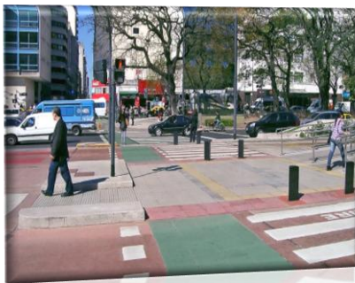
Cruce peatonal con rebaje de boulevard, cruce de bicisenda, elementos de protección vial, mosaicos guías y solado de prevención con diferencias de coloración. Ciudad de Bs. As.
