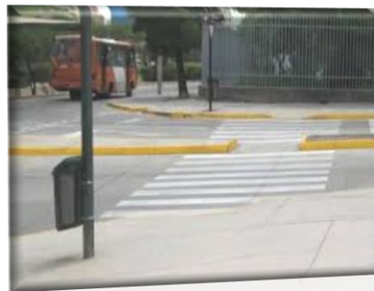
Cruce peatonal con rebaje de boulevard, incorrectamente implementado. Nótese que la amplitud del paso no coincide con las líneas y la luminaria obstruye el acceso al vado.
