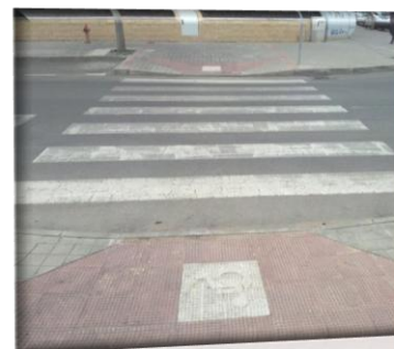
Cruce peatonal adaptado con vado señalizado correctamente, pero con deficiencias de mantenimiento.
