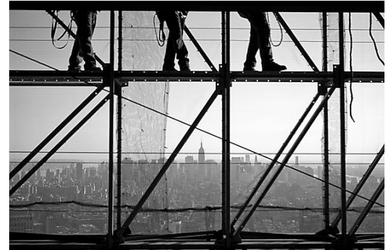
Andamio de construcción.
