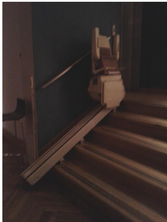
Fotografía 22: Plataforma vertical. Fuente: De Autor.
