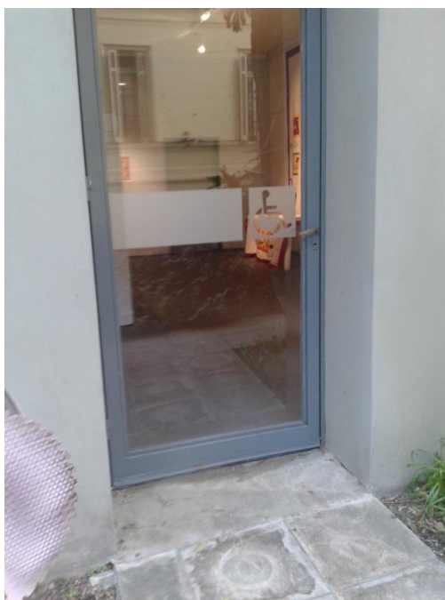
Fotografía 7: Entrada accesible señalizada. Fuente: De Autor.
