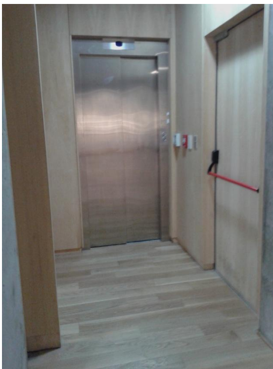
Fotografía 36: Ascensor estrecho. Fuente: De Autor.
