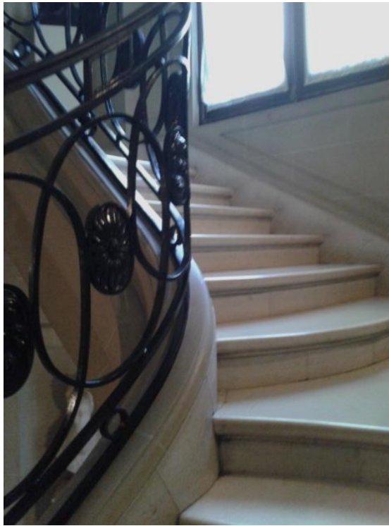
Fotografía 5: Escalera inaccesible al Primer piso. Fuente: De Autor.
