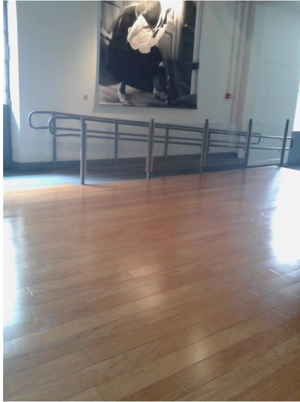
Fotografía 25: Rampa accesible. Fuente: De Autor.
