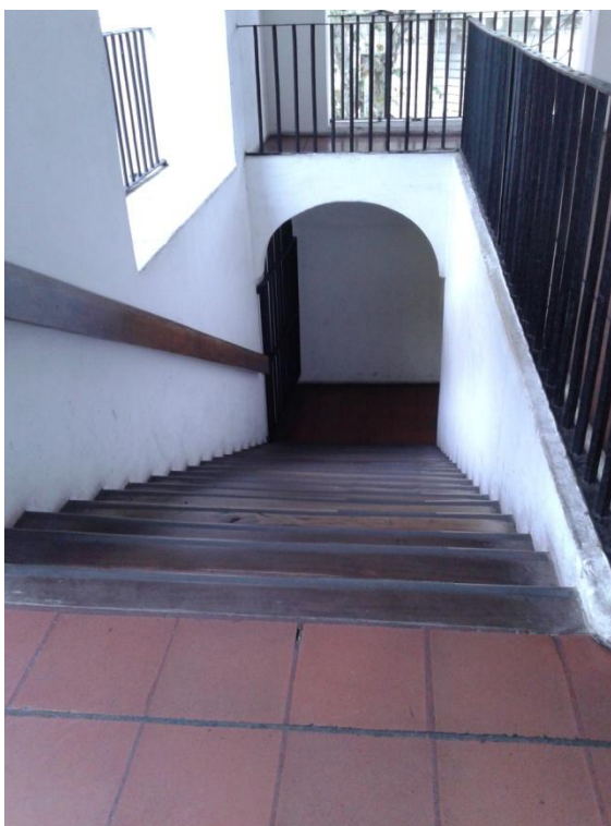
Fotografía 16: Escalera con solo una baranda, y con antideslizantes.
