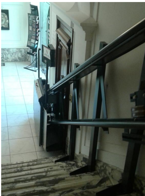
Fotografía 8: Plataforma vertical a primer piso. Fuente: De Autor.
