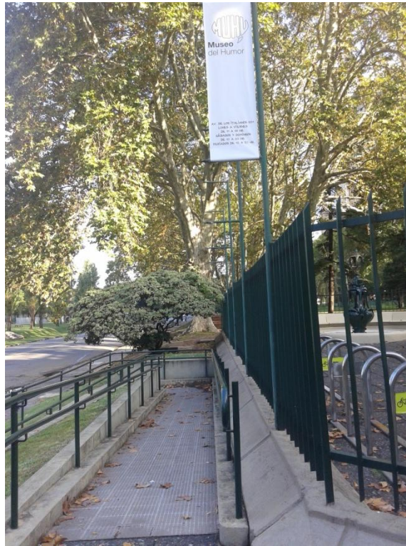
Fotografía 11: Rampa de Ingreso accesible. Fuente: De Autor.
