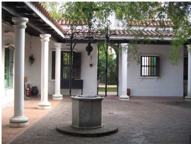
Fotografía patio de la casa colonial. Fuente: detrasdelafachada
