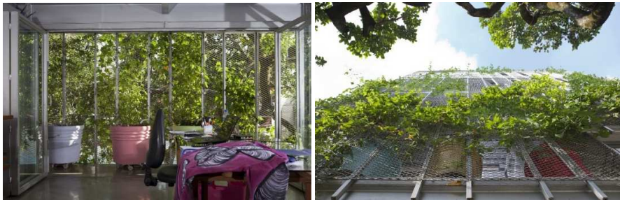
Fotografía ilustrativa edificio jardín. Fuente: plataformaarquitectura
