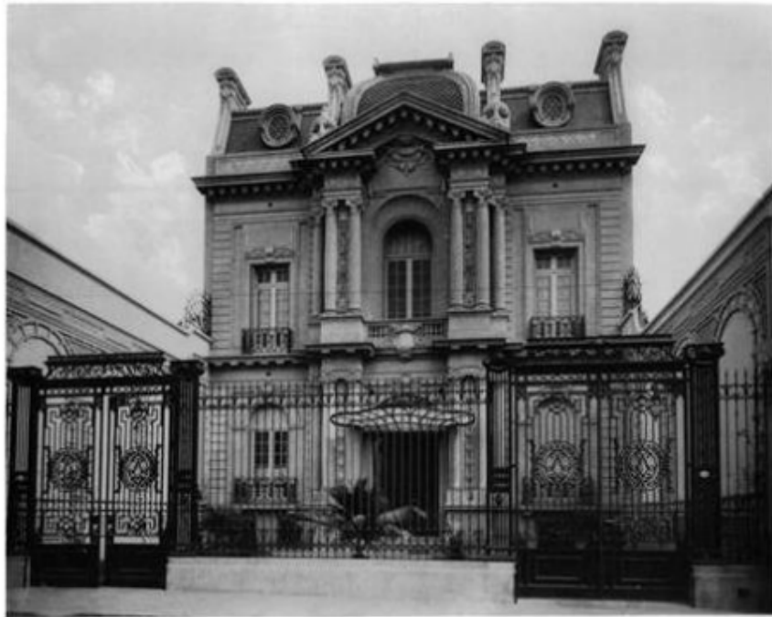
Fotografía fachada de Petit Hotel. Fuente: arquitecto-christophersen
