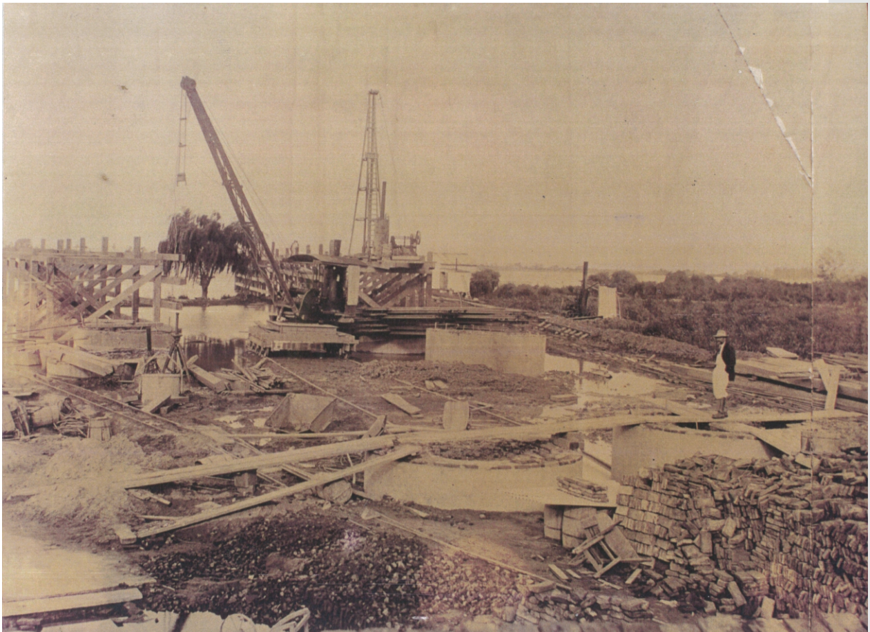
Construcción del Puente de Transferencia
