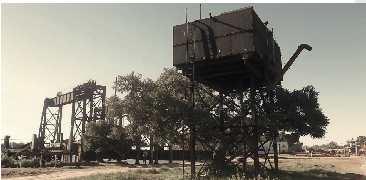
Equipamiento ferroviario Puerto Ibicuy
