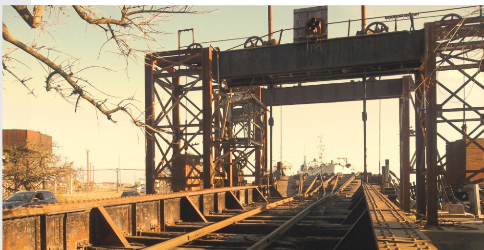
Puente de Transferencia actual
