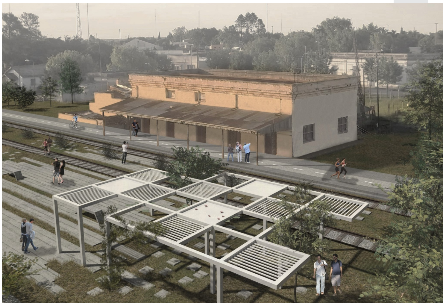
Intervención sobre espacios vinculados a la Estación de Tren HOLT IBICUY
