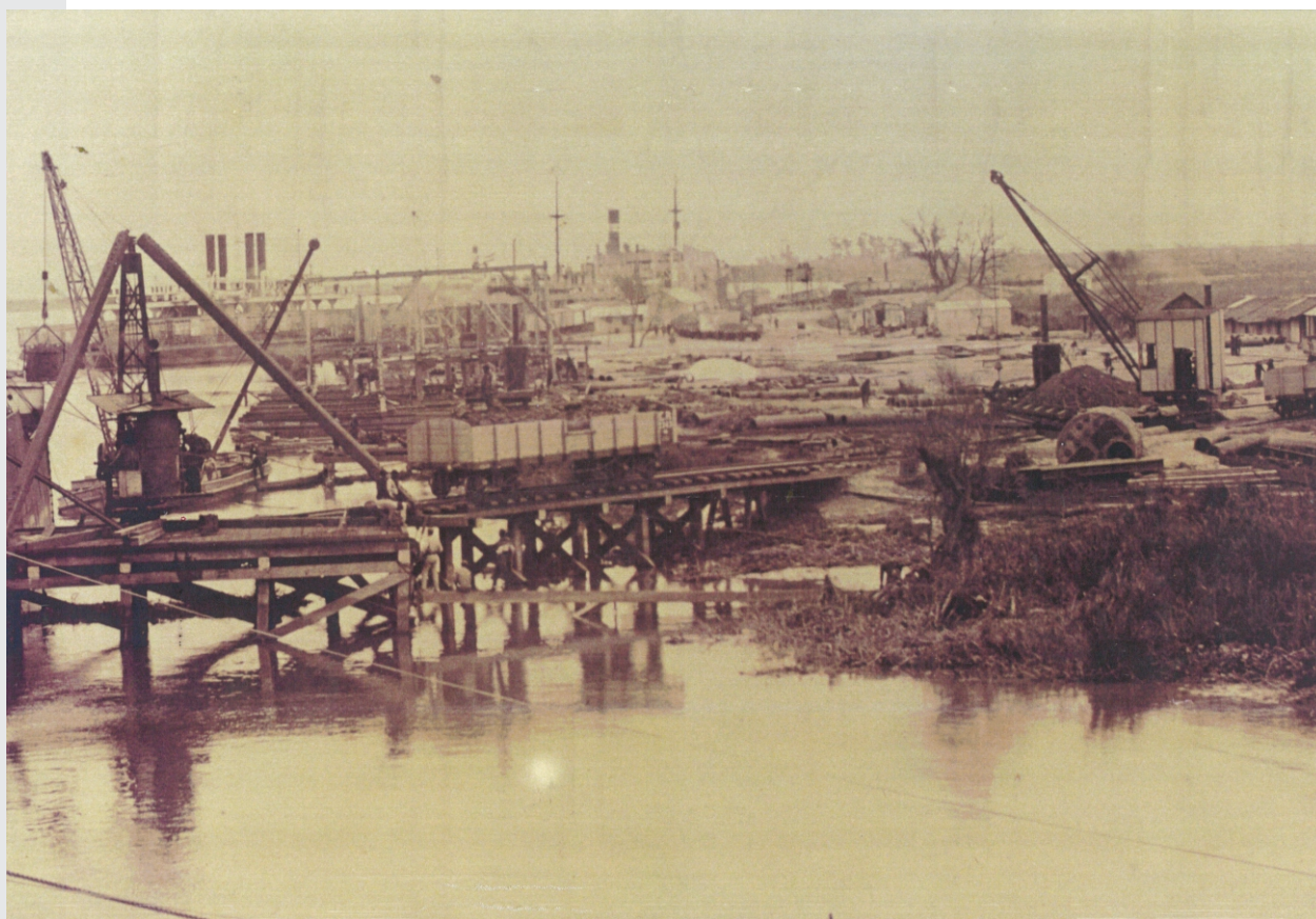
Construcción de Puerto Ibicuy
