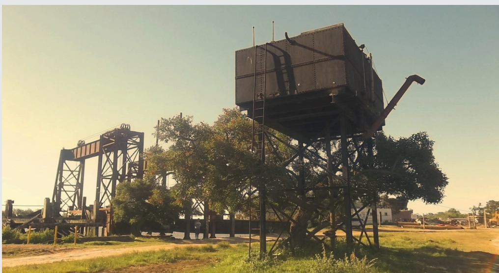
Tanque de reserva.
