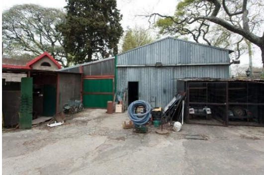
Edificios sin mantenimiento
