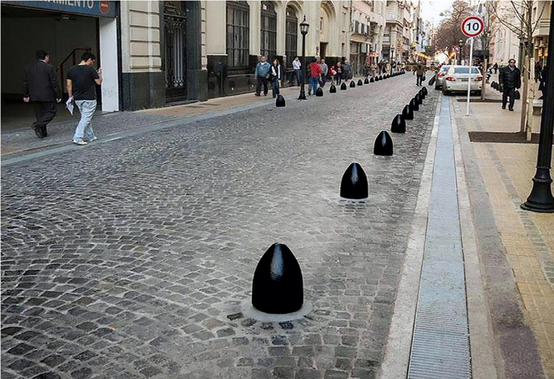
Adoquinado de granitullo en calle Bolívar
