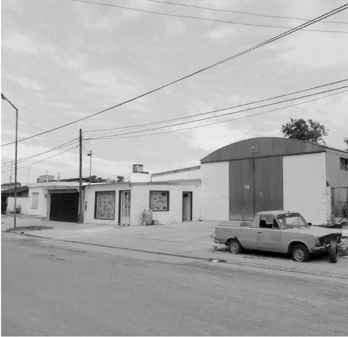
Talleres instalados en zonas residenciales.
